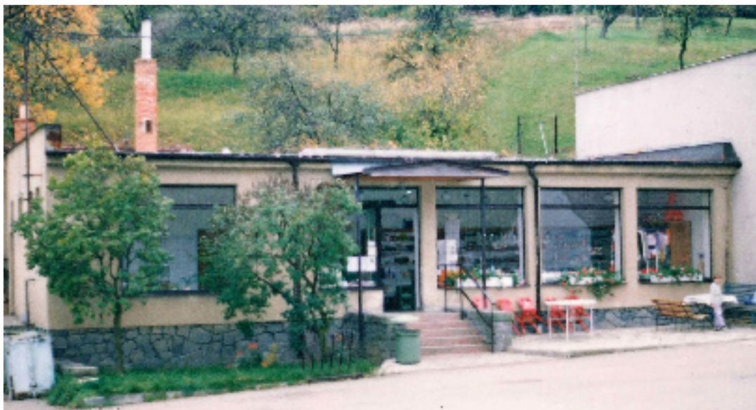
Původní vzhled budovy místní Jednoty dostavěné 1973, později byl obchod v soukromém vlastnictví.
