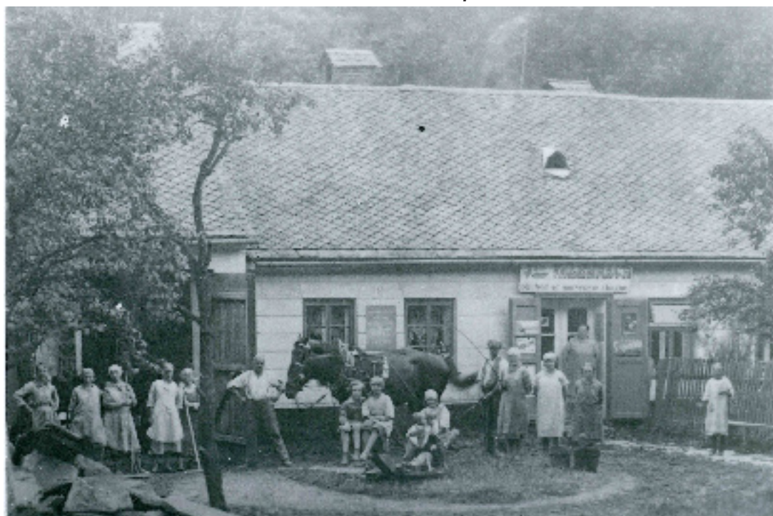
Fotografie domu Jana Valehracha, obchodníka se smíšeným zbožím. Před domem je žentour. Do něj byli zapřaženi koně. Chodili v kruhu a pomocí převodů vedených kanálem pod podlahou průjezdu byla jejich síla přenášena na pohon různých hospodářských strojů, například mlátičky obilí.
